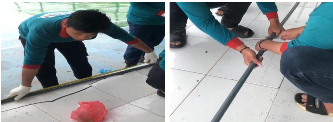
Figur 2. Proses pengukuran pipa 3/4 inci dan Proses pemotongan pipa 3/4 inci
