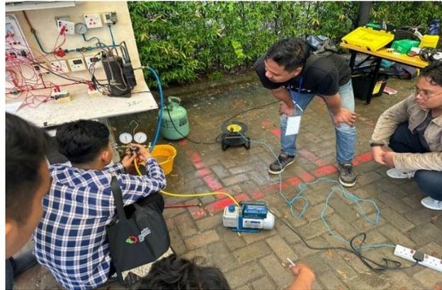
Figur 3. Pemvakuman dan Teknik *Recovery Refrigerant*
